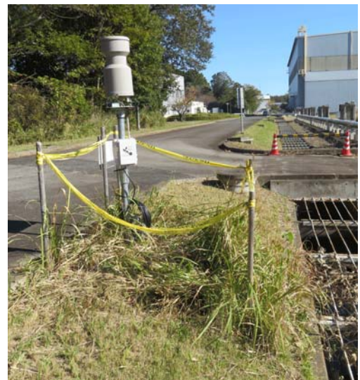
写真5 LoRa観測ノード雨量・水位
